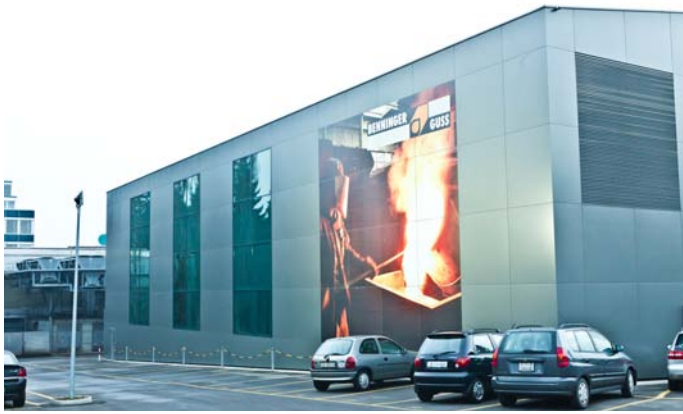
Spuren von Arson in Uzwil: Die Giesserei,...
