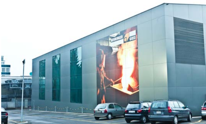
Spuren von Arson in Uzwil: Die Giesserei,...
